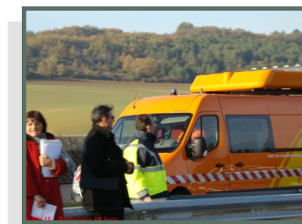
Travaux RN124 Auch/Gimont
