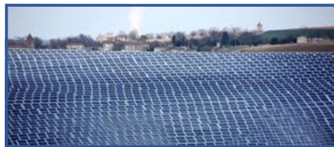
Centrale photovoltaïque de Saint Clar
