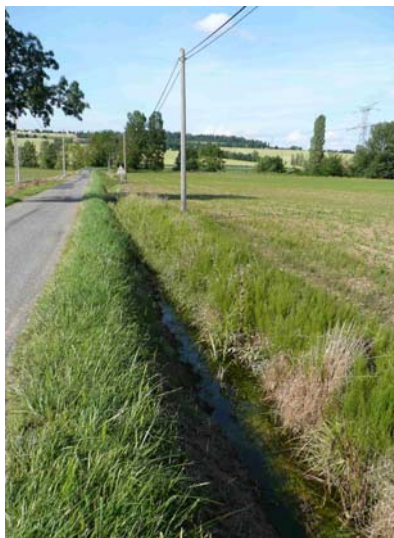
5. Fossé en eau (Verfeil-31)
