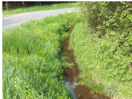
2. Cours d'eau déplacé (Le Margnès-81)
