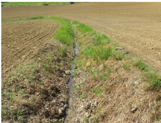
3. Cours d'eau recalibré (Vènès-81)
