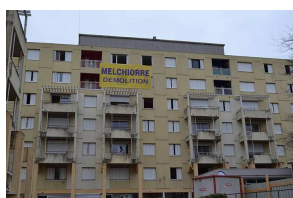
Démolition de deux tours
