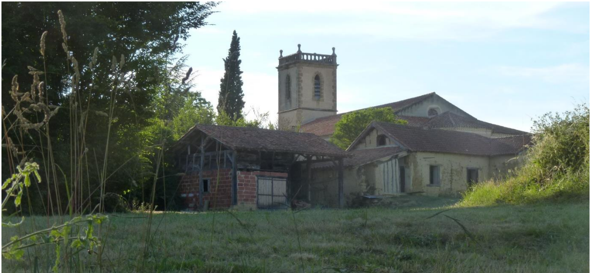
Photo 4: Bâtiment communal à restaurer et église
