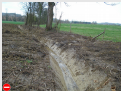
Reprofilage du lit et destruction de la végétation des berges.
