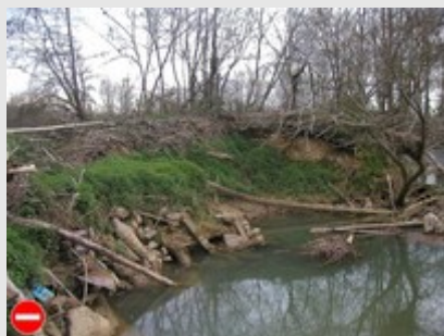
Décharge de déchets inertes, embâcles pouvant gêner l'écoulement ou être repris par les crues.
