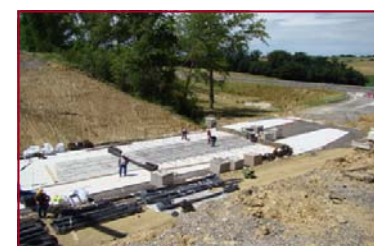
Travaux d'aménagement RN124
