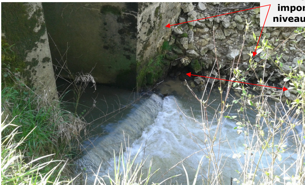
Seuil actuel sous le pont secondaire
