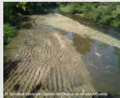
Exemple de grattage / scarification d'atterrissement composé de matériaux nobles.
