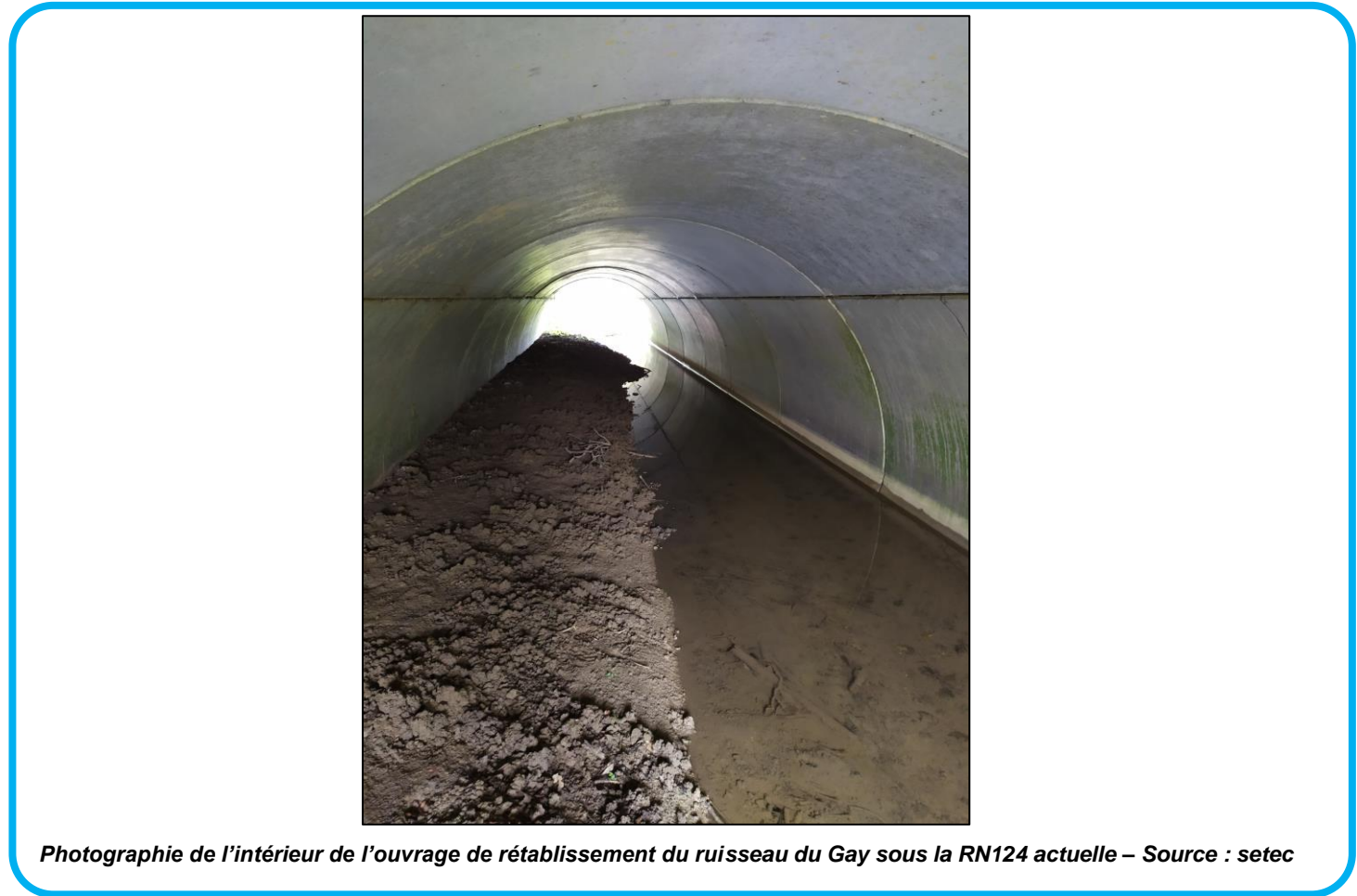
Exemple de banquette en encorbellement dans un ouvrage de type buse – Source : Guide Permettre à la faune de franchir les infrastructures linéaires de transport, CEREMA, 2019
