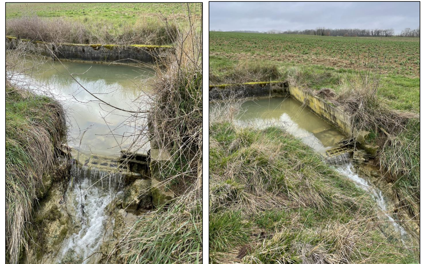
Ouvrage de surverse actuel
