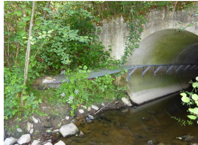
Exemple de banquette en encorbellement dans un ouvrage de type buse – Source : Guide Permettre à la faune de franchir les infrastructures linéaires de transport, CEREMA, 2019
