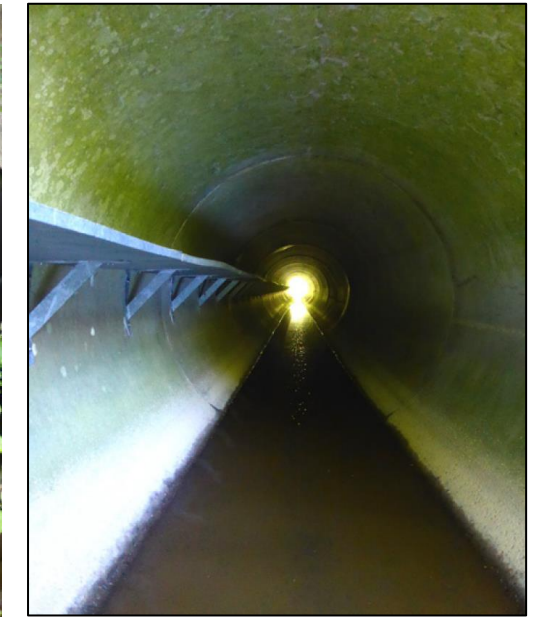
Exemple de banquette en encorbellement dans un ouvrage de type buse – Source : Guide Permettre à la faune de franchir les infrastructures linéaires de transport, CEREMA, 2019
