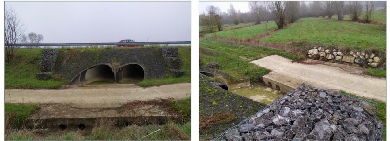
*Ouvrage de décharge sous la RN124 à l'Est du projet – Source : Setec*
