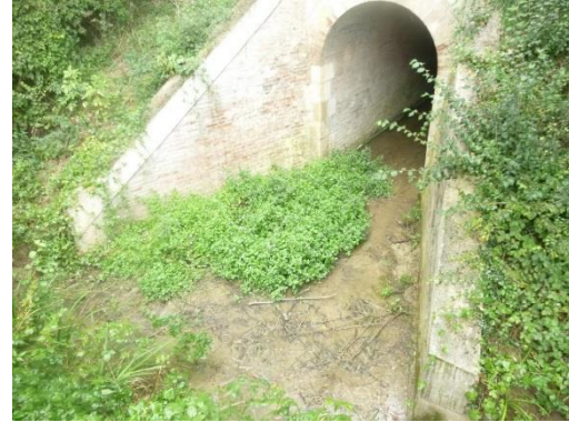
Confluence ruisseau de la Passade et ruisseau d'En Bon au niveau de la RD121
