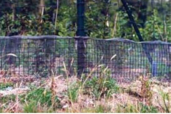
**Figure 31 : Treillis soudé à mailles fines adossé à une clôture à grandes mailles, avec la partie supérieure recourbée et la partie inférieure enterrée – Source : Biotopie en haut et J. Carsignol, SETRA 2008 en bas**
