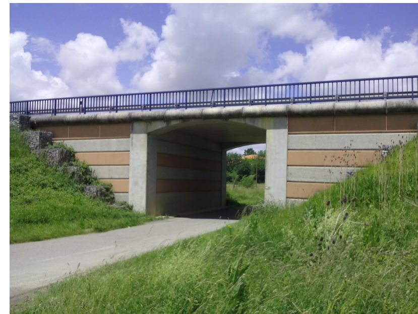
Passage inférieur sous la RN124
