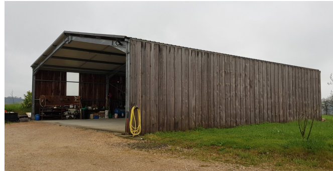
Source : Batiment agricole à Samatan (32)
