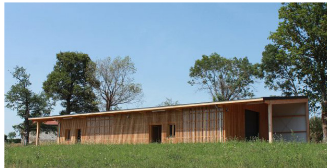
Source : FABRIQUES ARCHITECTURE ET PAYSAGE, Bâtiment de maraichage à Neulise
