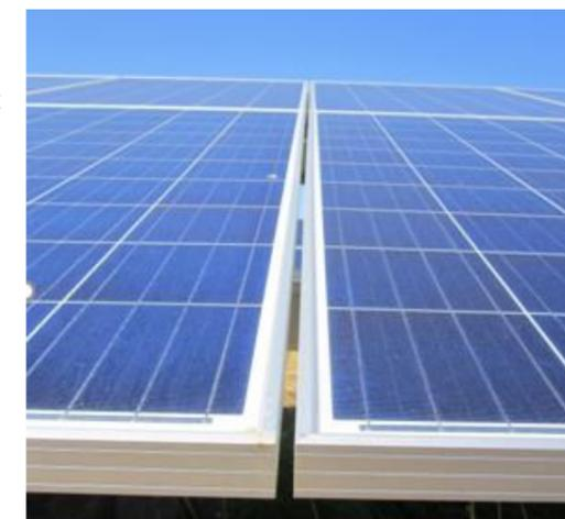
Photographie 5 : Espacement entre les modules photovoltaïques (source : ENCIS Environnement)
