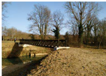
3 - Abords de la passerelle
