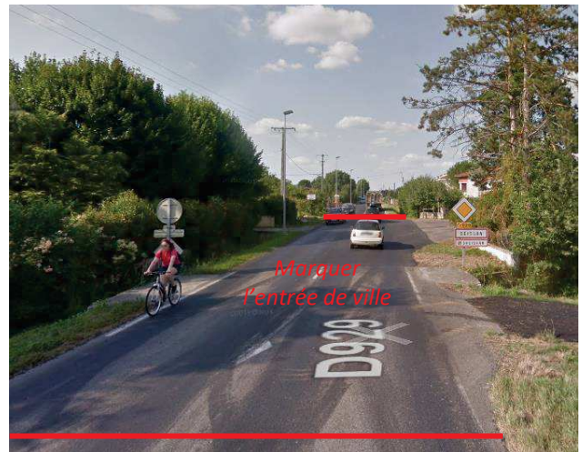
2 - Entrée de ville Sud - Depuis Lannemezan
