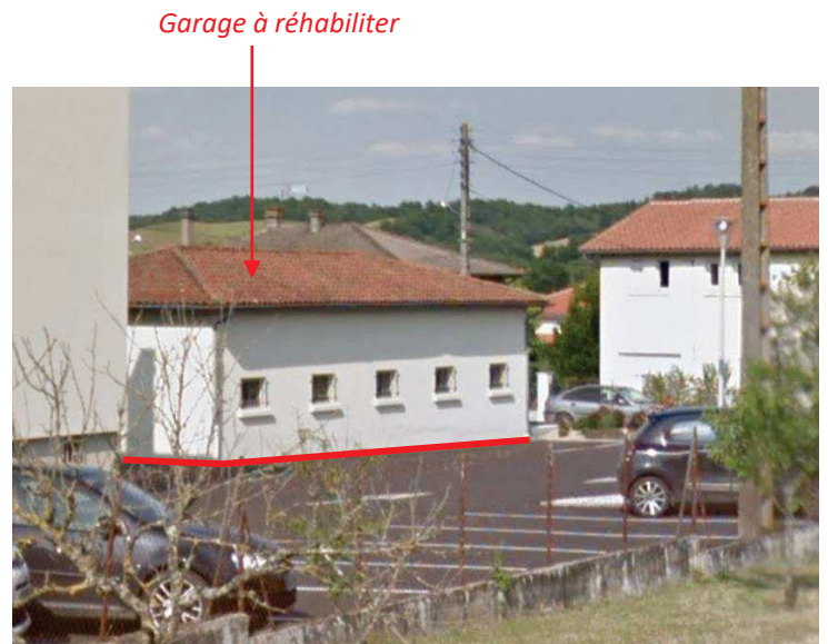
Vue 2 – Depuis l'Avenue des Pyrénées
