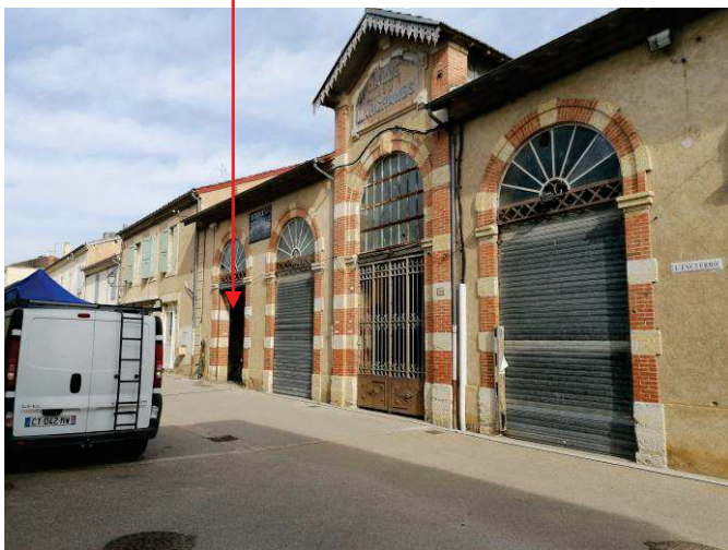
1 – Façade principale – Rue du marché
